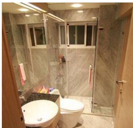
圖5.2-7 浴室照明採用LED 燈源
