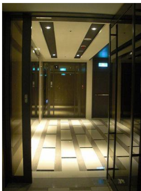
圖5.2-9 門廊樓梯間照明採用LED 燈源
