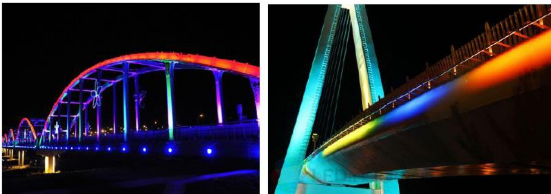
圖 2.3-1 LED 照明產品應用於橋樑實照圖
