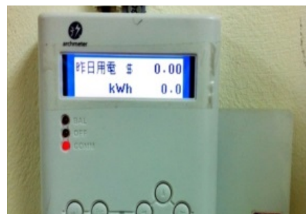
完成教室冷氣刷卡系統裝設
