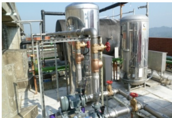
熱水供應系統(熱泵系統)
