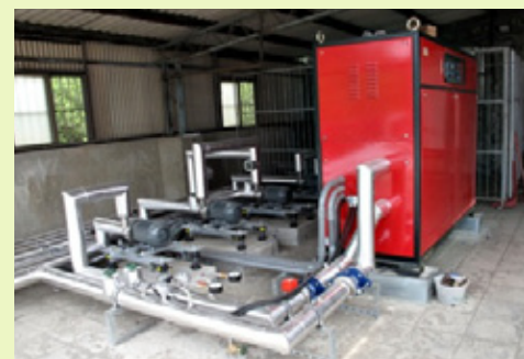
學生宿舍熱水供應裝設熱泵系統
