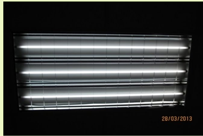
照明燈具汰換
